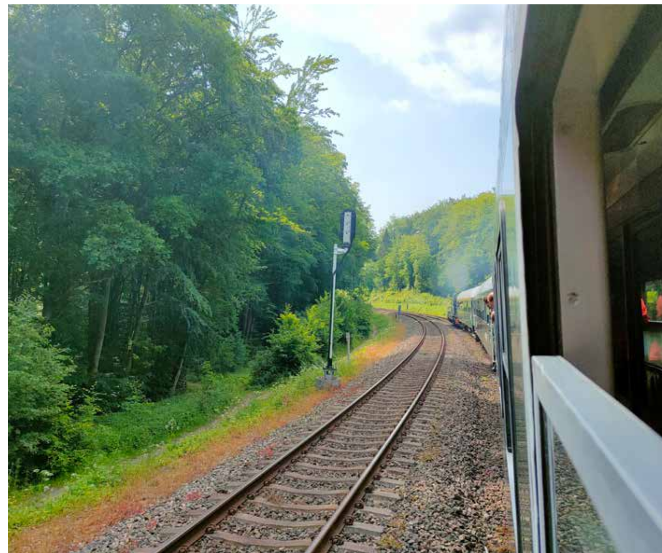
Pociąg „Magistrala” pokonuje łuk, zbliżając się do przystanku Gdynia Karwiny. Różnica wysokości między Gdynią Główną a Karwinami to ok. 100 metrów!
